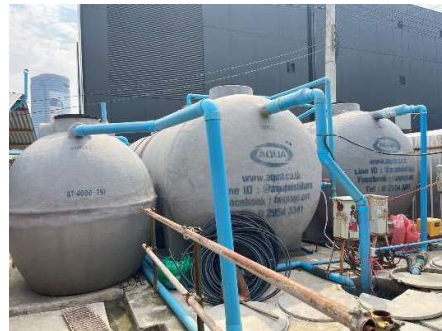
รูปที่ 50 ระบบบำบัดน้ำเสียสำเร็จรูป
