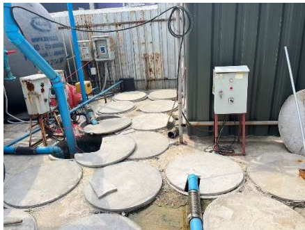
รูปที่ 50 ระบบบำบัดน้ำเสียสำเร็จรูป
