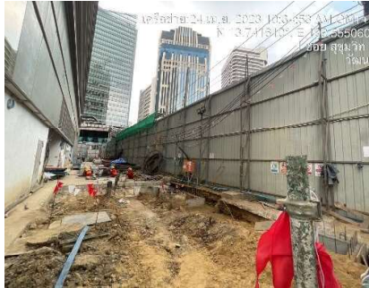
รูปที่ 1 รั้ว Metal Sheet สูง 6 เมตร ล้อมรอบพื้นที่โครงการ
