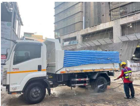
รูปที่ 29 การทำความสะอาดล้อรถ
